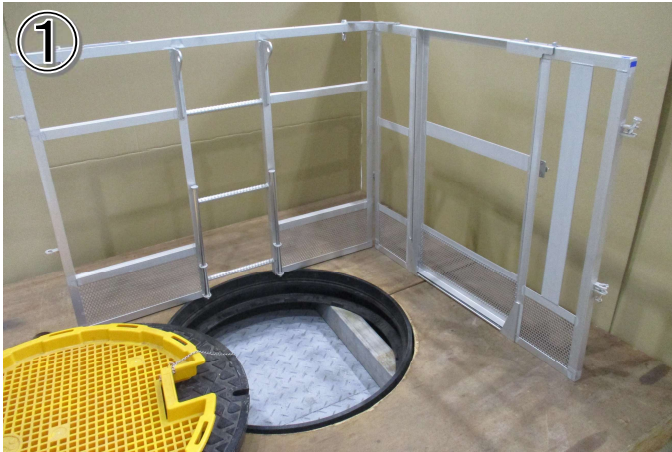
① 開口部に防護柵A・Bを設置し連結
