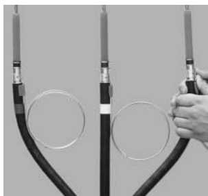
接地クランプ取付け
